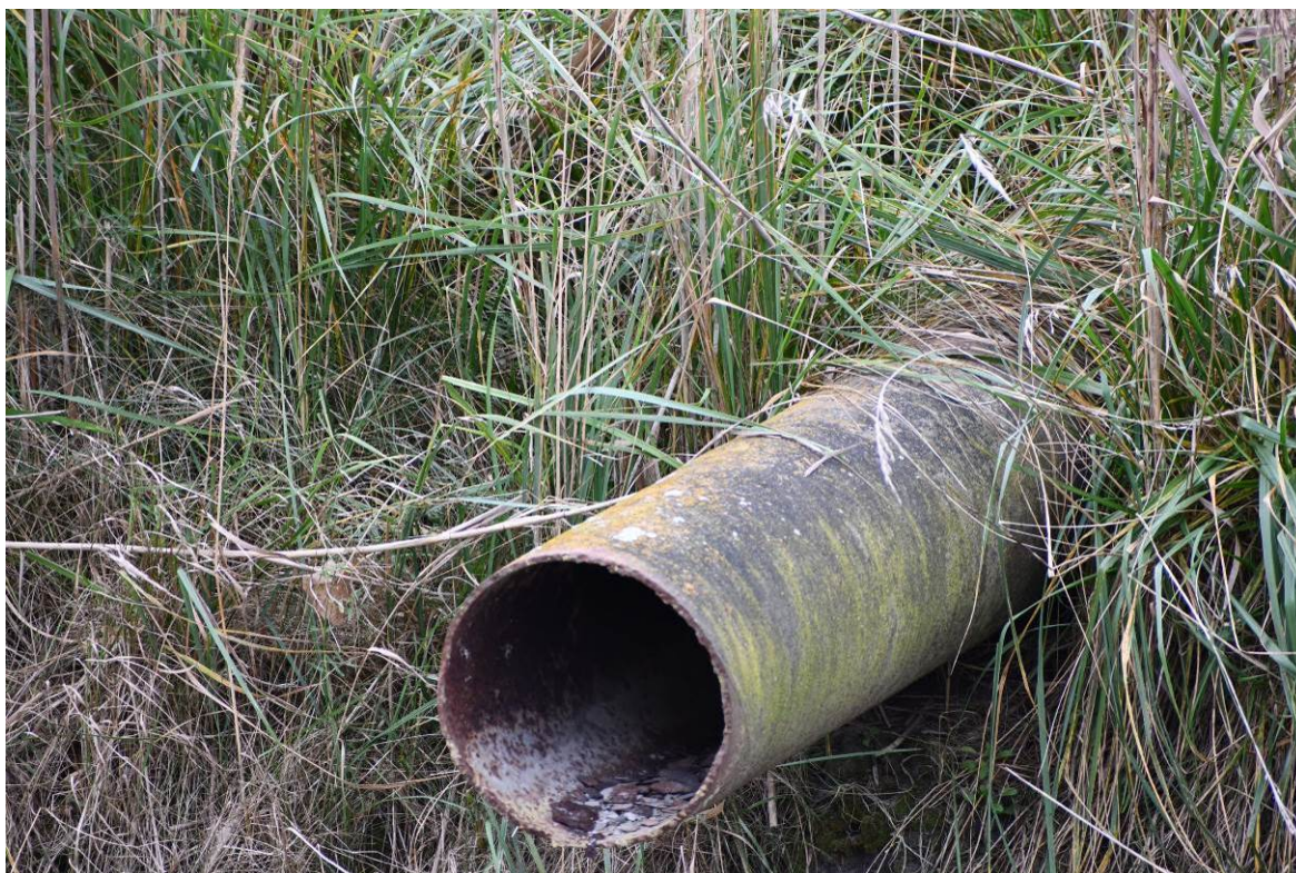
Fot. Widok na obszar opracowania – wylot z instalacji technologicznej w granicach wyłączonego z eksploatacji/nieczynnego zbiornika.
