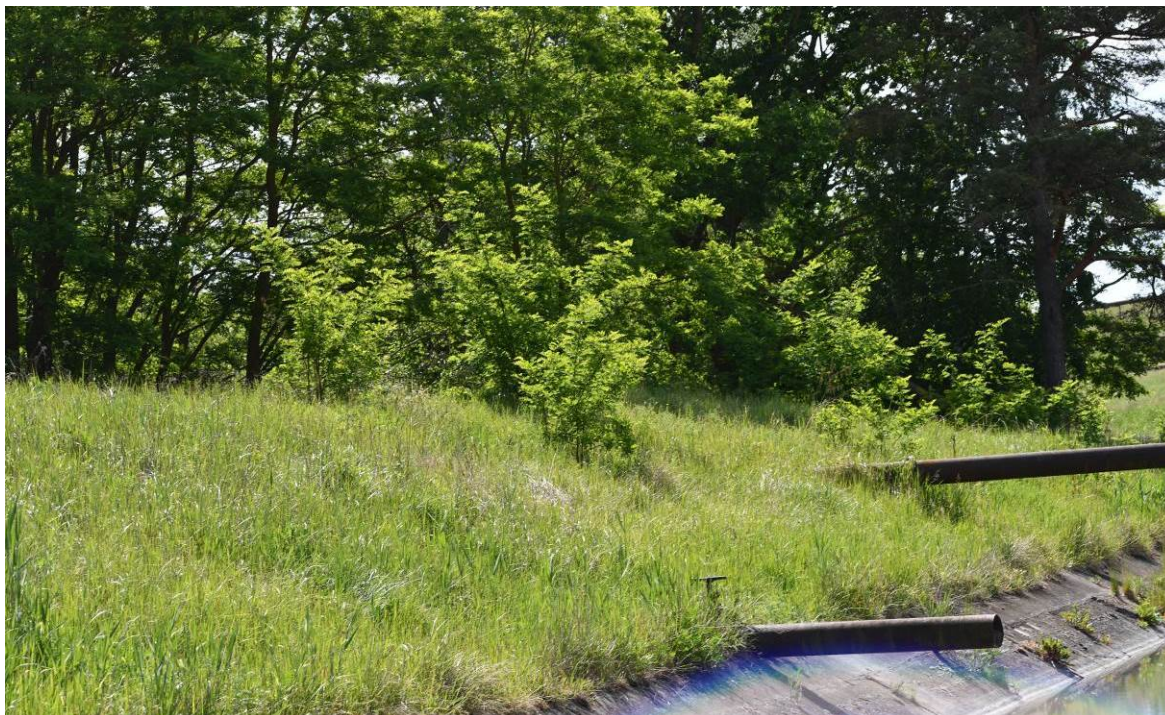
Fot. Widok na południowo – zachodnią część obszaru opracowania od strony północnej (dz. nr 104/4) – otwarty rów, instalacje technologiczne (rurociągi), skarpa porośnięta przez roślinność niską oraz drzewa rosnące powyżej skarpy.
