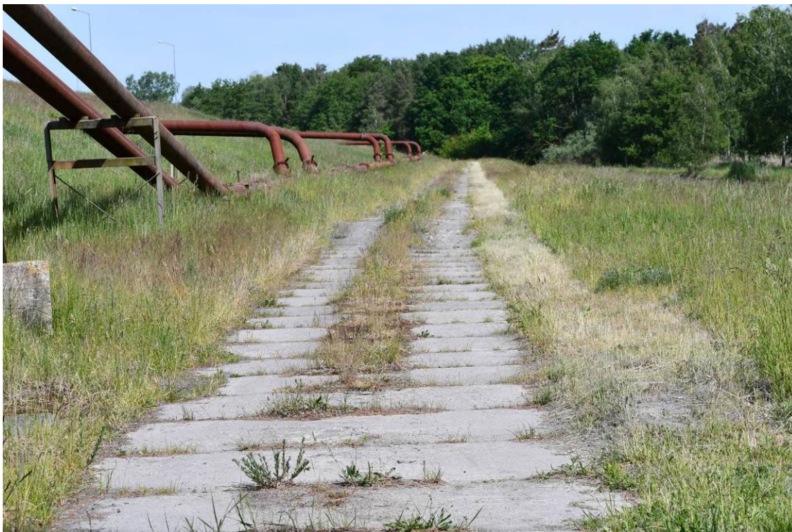
Fot. Widok na południowo – zachodnią część obszaru opracowania od strony południowej - teren porośnięty przez roślinność niską, droga o nawierzchni z płyt betonowych i rurociągi oraz w kierunku terenu poza granicami działki nr 104/4 po jej stronie północno – zachodniej - dalsza część drogi i rurociągów oraz zadrzewienia (dz. nr 118/67).
